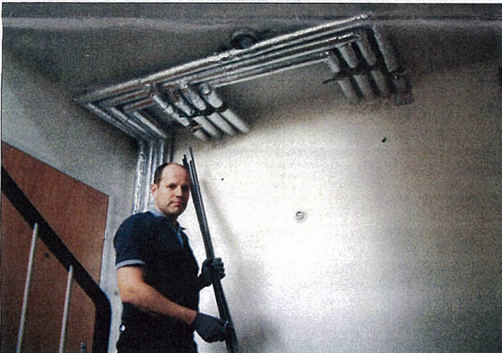
Käyttövesiputket johdetaan porrashuoneisiin ja ne sijoitetaan siististi seinä- ja kattorakenteiden taakse. Kuvassa alhaalla vasemmalta projektipäällikkö Jukka Viljanen, Remonttipartio Oy:stä, puheenjohtaja Seppo Savolainen AsOy Aapelinkatu 5:stä ja isännöitsijä Jukka Koivisto Espoon Isännöinti Oy:stä.
